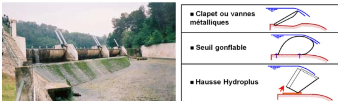
Photo.2. Clapets commandés par vérins. (Photo- Irstea - G2DR).
