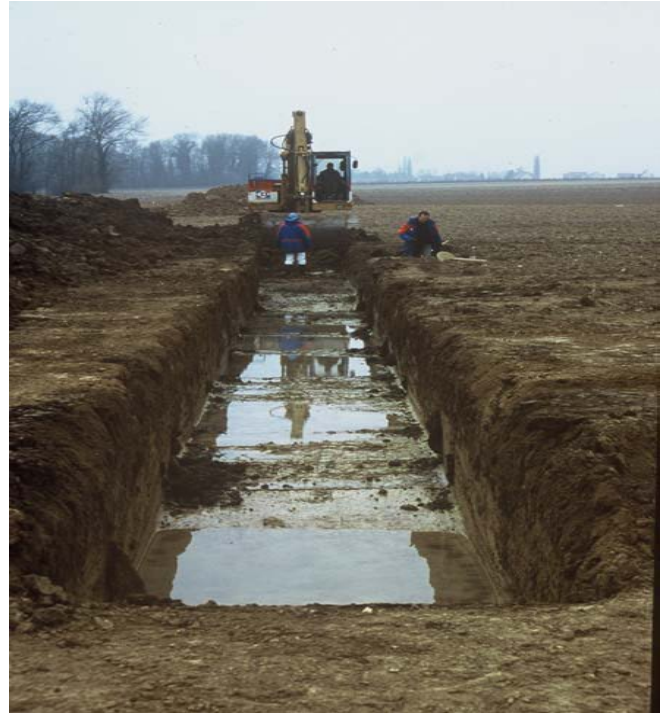
Sondage à la pelle mécanique
