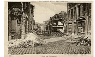
Rue de Ronchin après l'explosion des dix-huit ponts.
