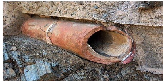
Aqueduc en canalisation de céramique noyée dans du mortier
