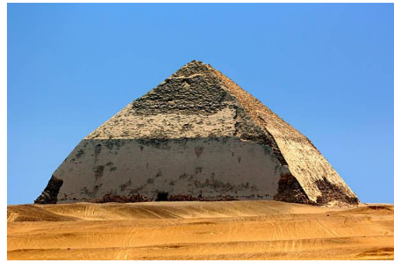
Figure 60. Pyramide à deux plans inclinés, le 1 er de 58° de pente, le second de 43° 22'. vers la pointe. Cette rupture de pente serait due à un changement de plan intervenu durant la construction
