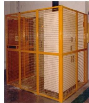
Figure II.7 : Utilisation d'obstacle : grillage (protection collective)
