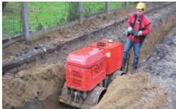
Figure III. 15 : Réduction des vibrations par utilisation d'engins téléguidés
