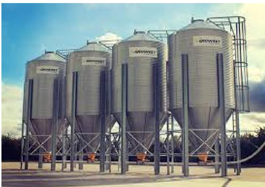
**Figure 21:** Photographie des silos verticaux métalliques utilisés pour le stockage des graines oléagineuses.
