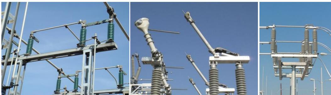
Figure II. 7 : Sectionneur de poste HT
