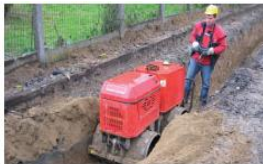
Figure IX.10 : Réduction des vibrations par utilisation d'engins téléguidés
