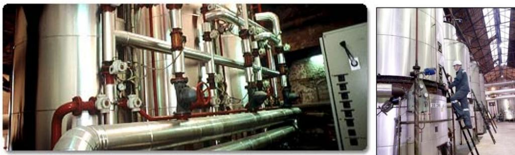
Figure 25 : Système d'évaporation en sucrerie
