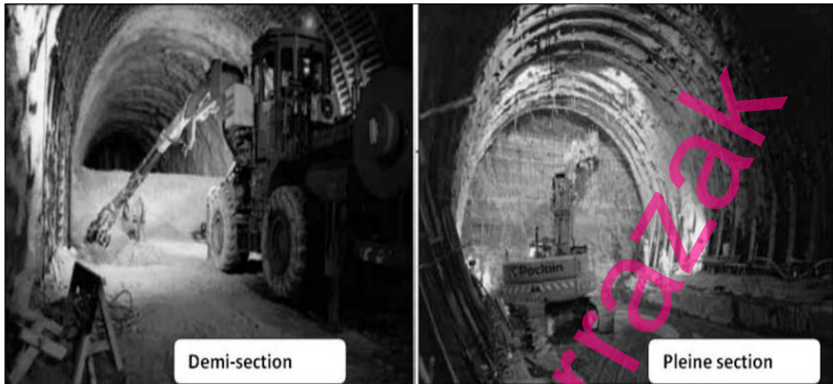
Figure. 7. Creusement des excavations par pleine et demi section. [38].
