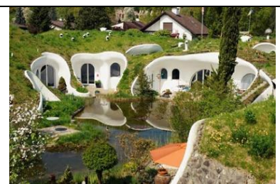
Figure 158 : Maisons organiques (2007) Architecte Peter Vetsch Dietikon, Suisse. Source : Virgine Maneval
