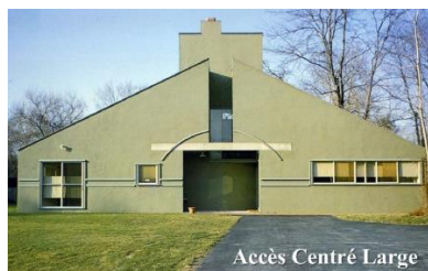
Figure 211 : Maison de Mr, Robert Venturi. Chestnut Hill. Pennsylvanie. 1962-64. Venturi and Short. Source : © Maria Buszek
