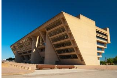
Figure 95 : Hôtel de ville de Dallas (USA). Architect: Ieoh Ming Pei 1978. Source : © Getty / Photo Davel5957
