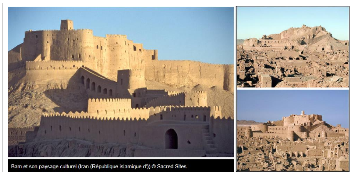
Figure 13 : site de Bam avant et après le séisme de 2003. Source Bam Iran earthquake (uoa.gr)
