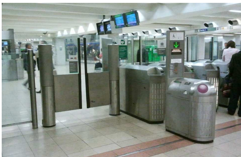
Figure 10 - Un valideur à passage élargi motorisé.
