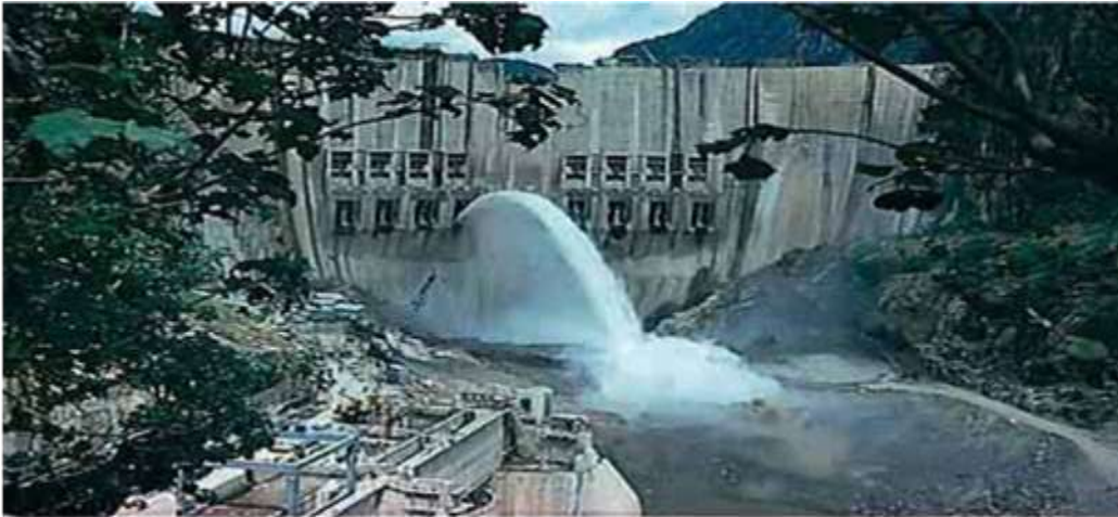
Barrage à accumulation de Cabora Bassa (Mozambique)
