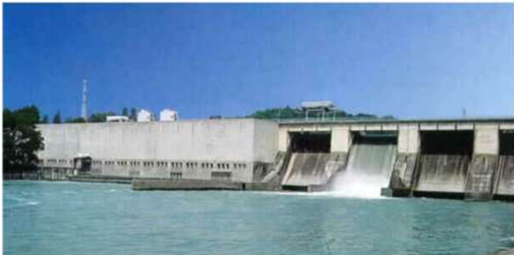
Centrale au fil de l'eau
