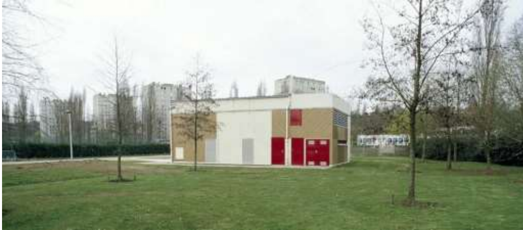
Fig. III.2 Pile à combustible stationnaire
