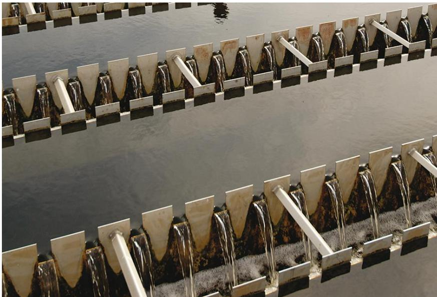
**Figure 4.6.** Décanteur physico-chimique à recirculation de boues externes.
