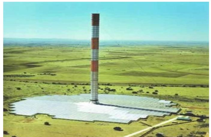
Figure IV.31 Schéma d'une tour solaire à effet de cheminée
