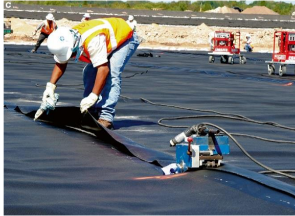
Figure 2.11 : Pose des géomembranes sur le fond des casiers d'un CET
