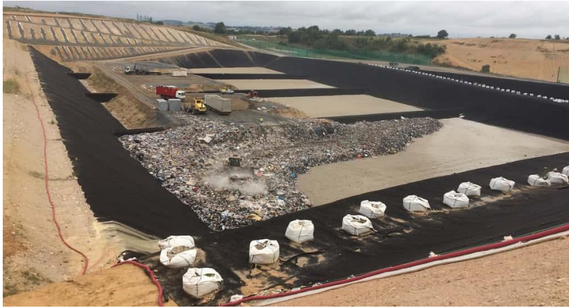
Figure 2.10 : Décharge en casiers séparés en exploitation
