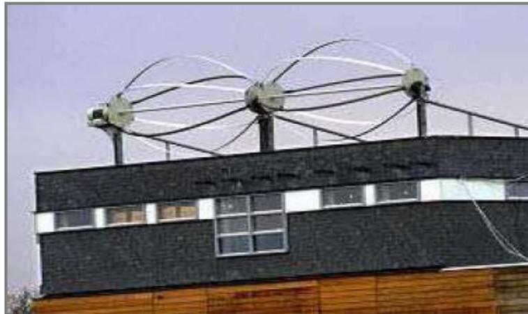
**Figure 5. Rotor a axe verticale de type Darrieus**
