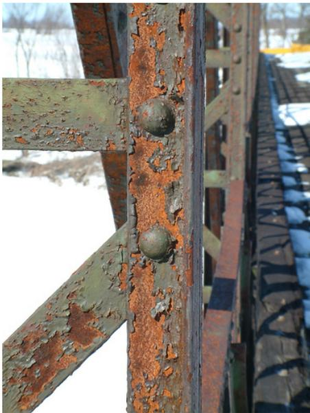
**Figure 1.** L'exposition au dioxygène et à l'eau fait rouiller la structure d'un pont.
