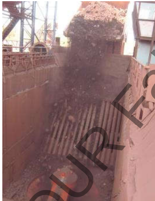
Figure II.4 : Concasseur giratoire d'une installation de préparation des minerais
