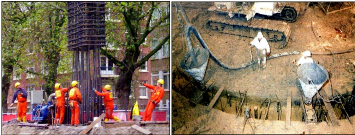
Figure IV-5: Réalisation et coulage des parois moulées dans le cadre du projet
