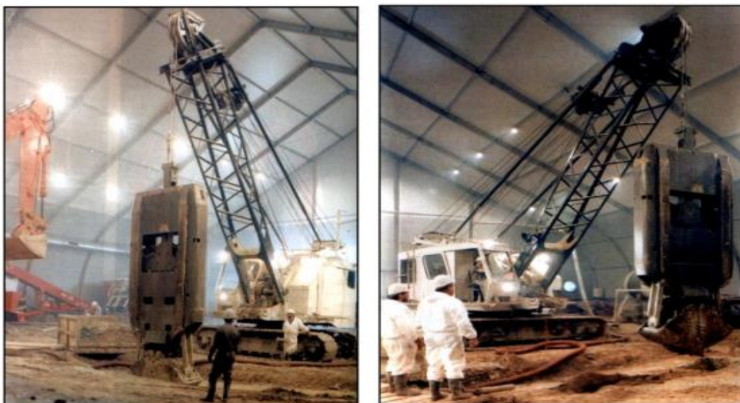
Figure IV-1: Chantier de réalisation d'une paroi moulée circulaire.
