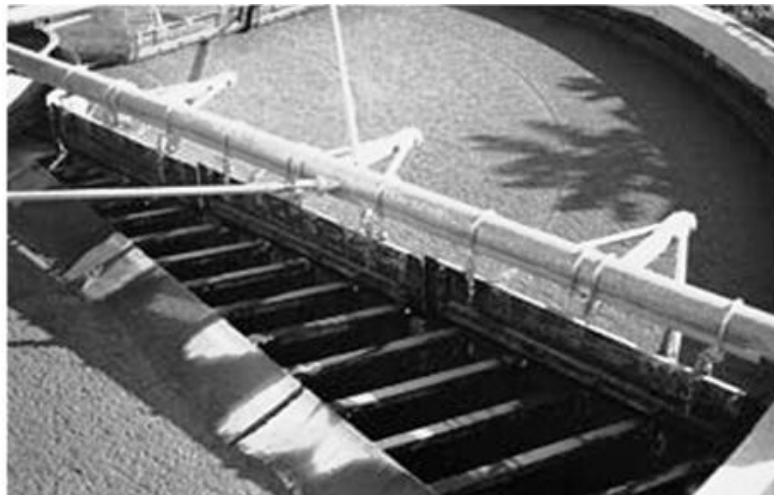
Figure III 12 : Disque biologique rotatif.
