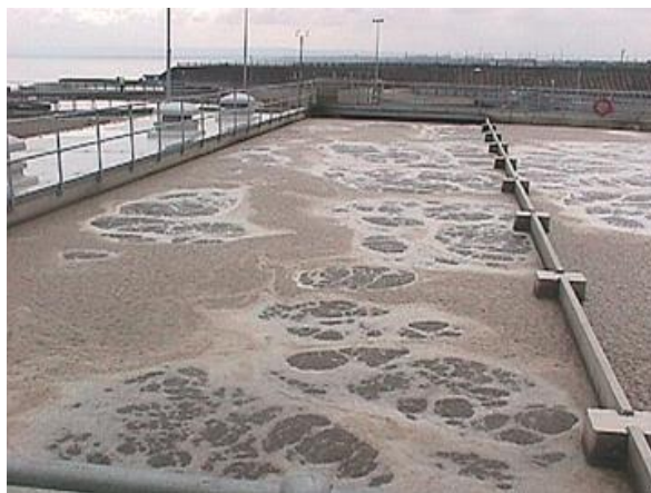
Figure III.4: Image d'une épuration biologique à boue activée.
