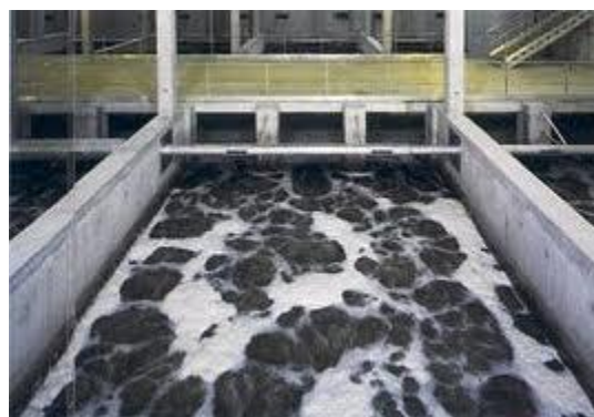
Figure III.3 : Image d'une épuration biologique par biofiltration
