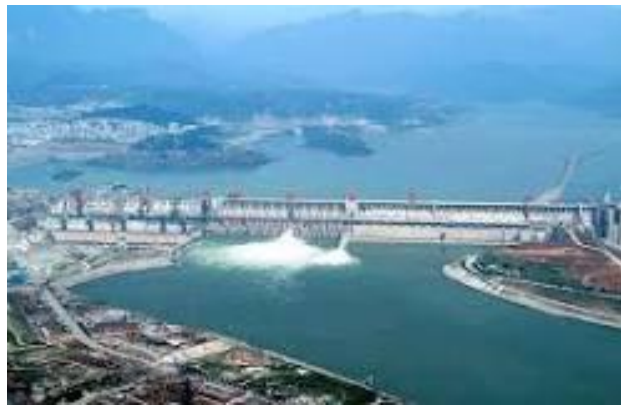
Fig. 5. 2: Le barrage des Trois-Gorges en Chine
