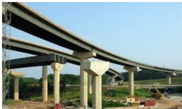
Fig. 5. 18: Pont mixte en acier béton
