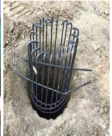
Fig. 2. 10: Ferrailage de pieux avant Bétonnage.
