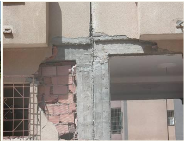
Fig. 3. 21 : Épaisseur minime des joints
