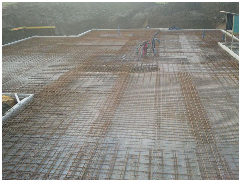
Fig. 2. 4: Ferraillage de fondation type radier.
