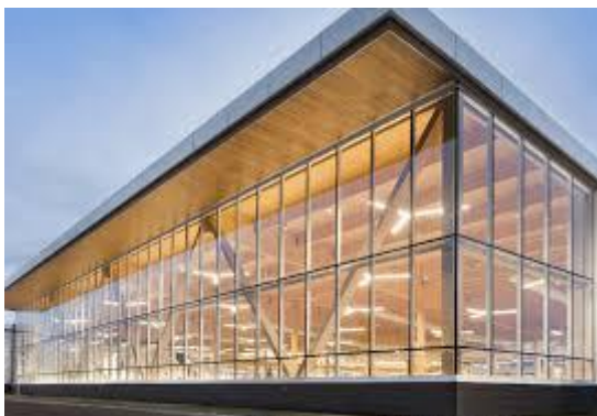
Fig. 5. 17: Structure mixtes en acier-bois
