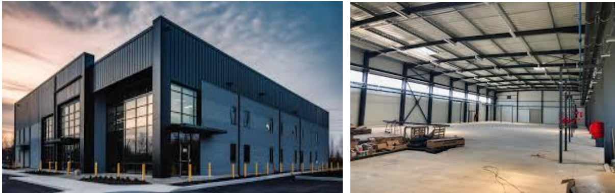
Fig. 4. 1: Des bâtiments industriels
