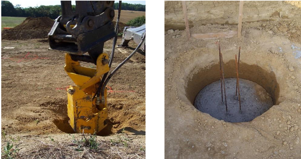
Fig. 2. 6 : La mise en œuvre d'un puits
