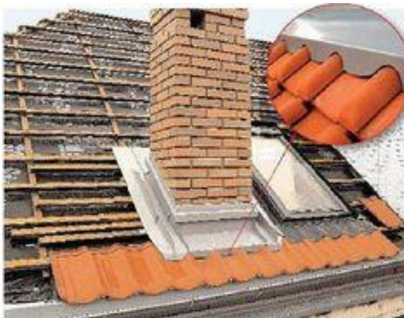
Le traitement d'étanchéité du soin des cheminées se fait actuellement par des procédés en zinc couplé avec de la calandrite si nécessaire
