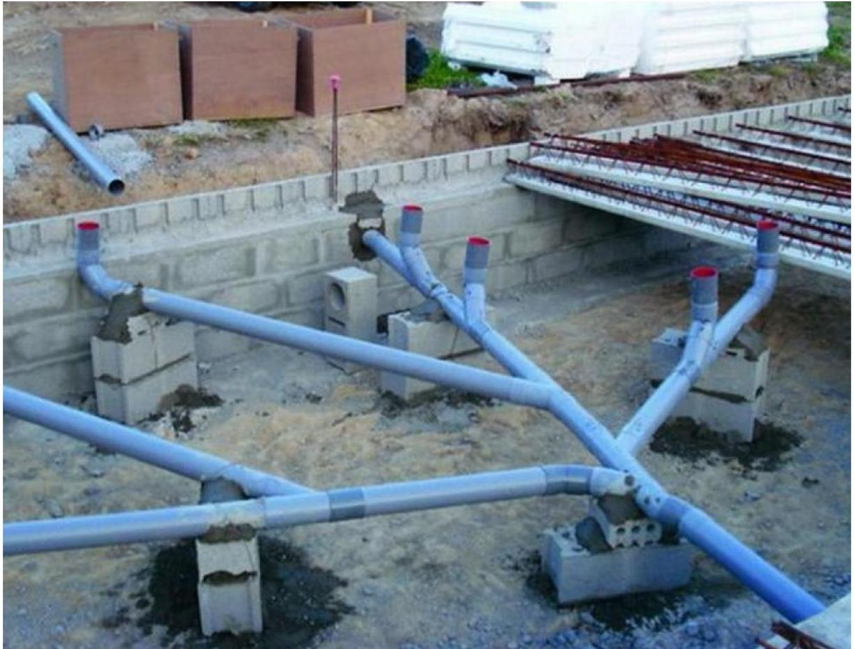
Figure N°64: La mise en œuvre des collecteurs d'un bâtiment
