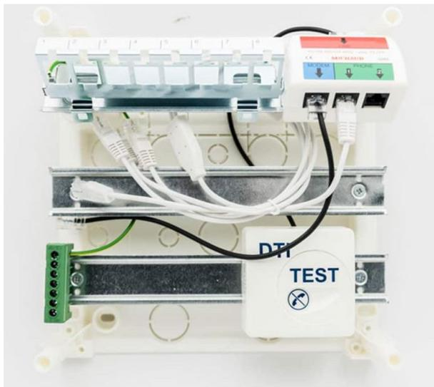
Figure N°60 : Tableau de communication pré-équipé
