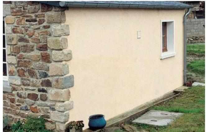
Figure N°84 : Crépi ou enduit ciment teinté dans la masse (coloré)
