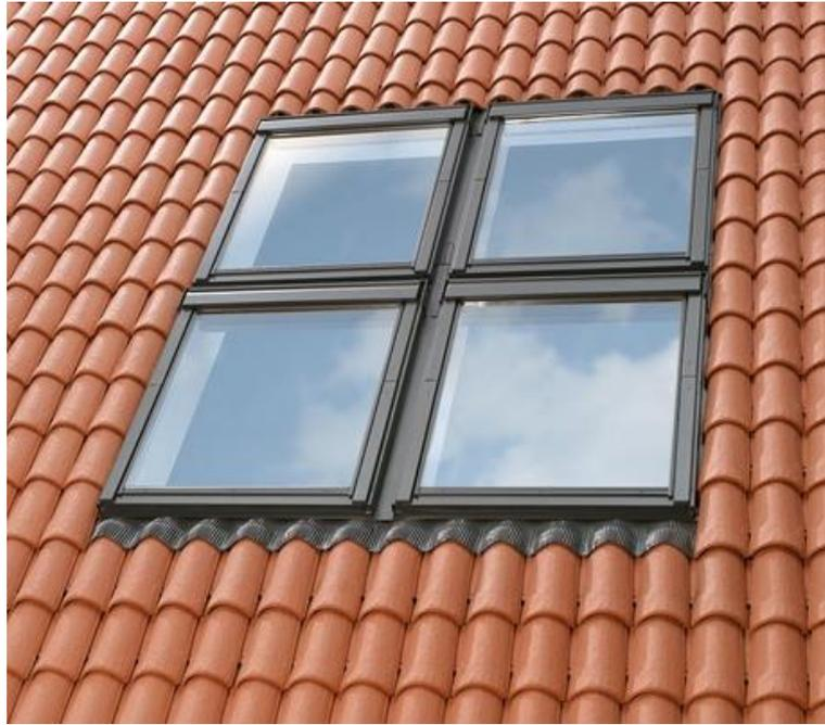
Le traitement d'étanchéité des fenêtres de toit s'effectue par des raccords des fabricants des fenêtres de toit adaptés à tout type de tuile
