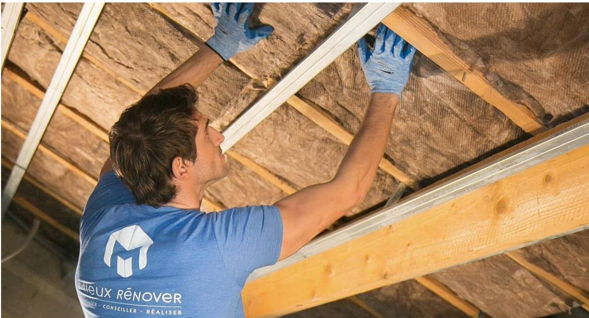
Figure N°98 : Isolation des toits rampants en simple couche
