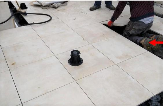
Les dalles forment la surface circulaire et protègent l'étanchéité
