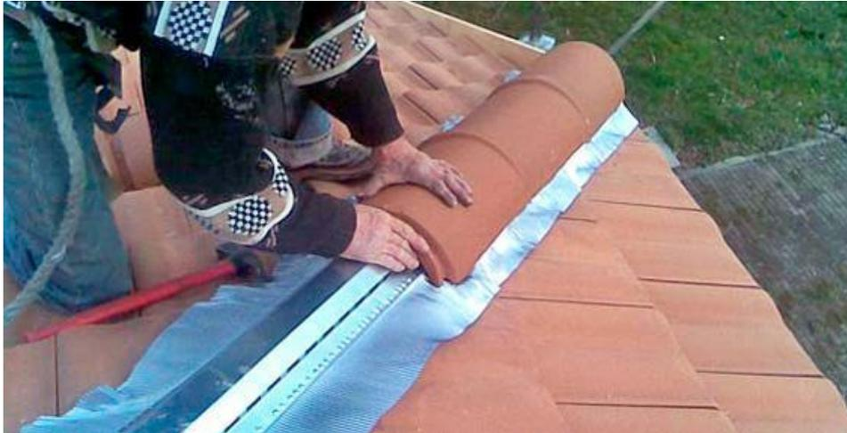
Le traitement d'étanchéité des points faibles d'une toiture en tuile « Faitage traitement par glossaires »
