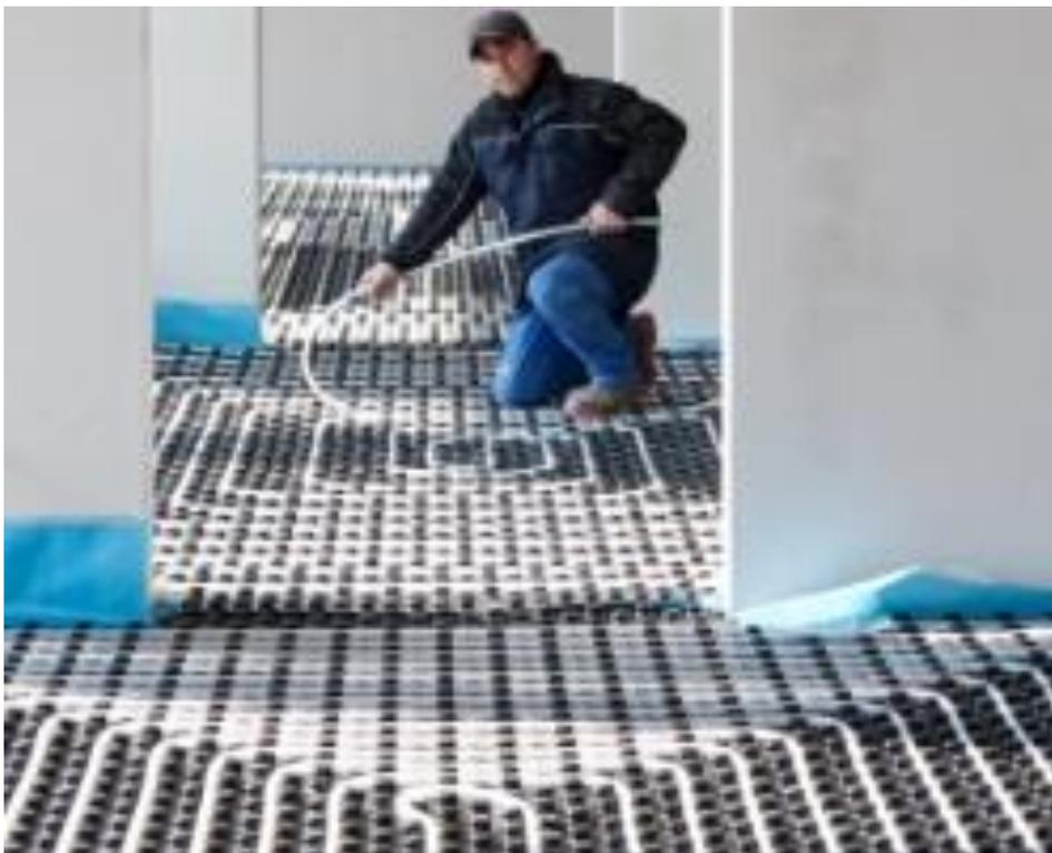
Figure N°75 : Illustration de la mise en œuvre d'un chauffage au sol
