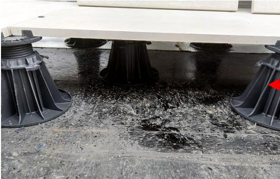
Dalle sur plots, posée directement sur le revêtement d'étanchéité
