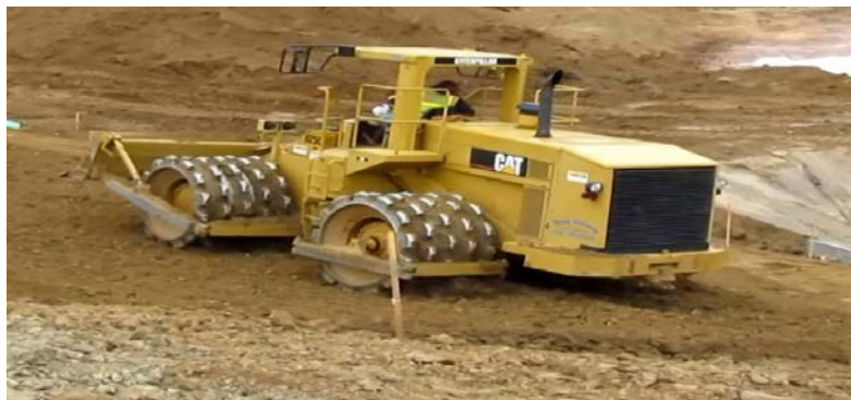
Photo 6. Compactage du sol
