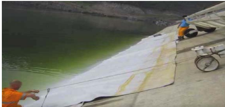
Photo 7. Pose du dispositif anti-filtration sur la pente du barrage.
