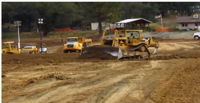
Photo 4. Grattoir pour préparation de fondation
