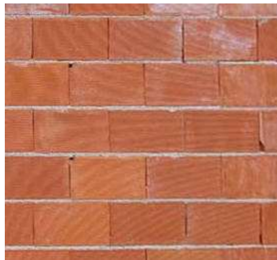
Figure 5-2 Mur en Brique
