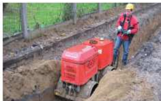
Figure IX.10 : Réduction des vibrations par utilisation d'engins téléguidés
