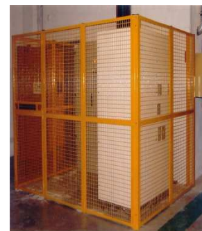
Figure V.5 : Utilisation d'obstacle : grillage (protection collective)
