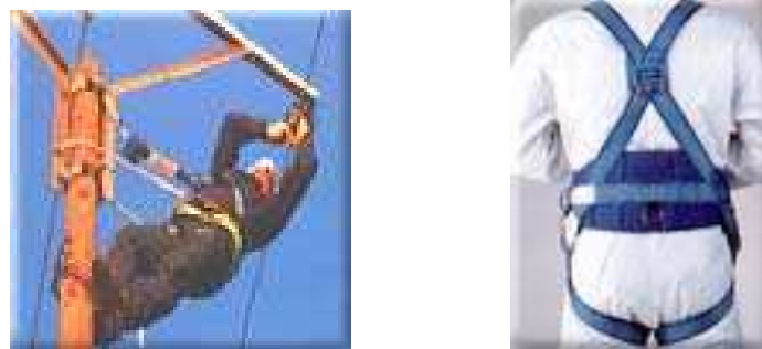
Figure VII.10 : Les harnais pour travaux en hauteur
