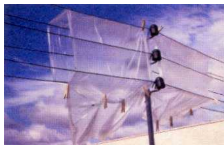
Figure VI.19 : Enveloppe de pièces nues sous tension avec nappes, capuchons et pinces
