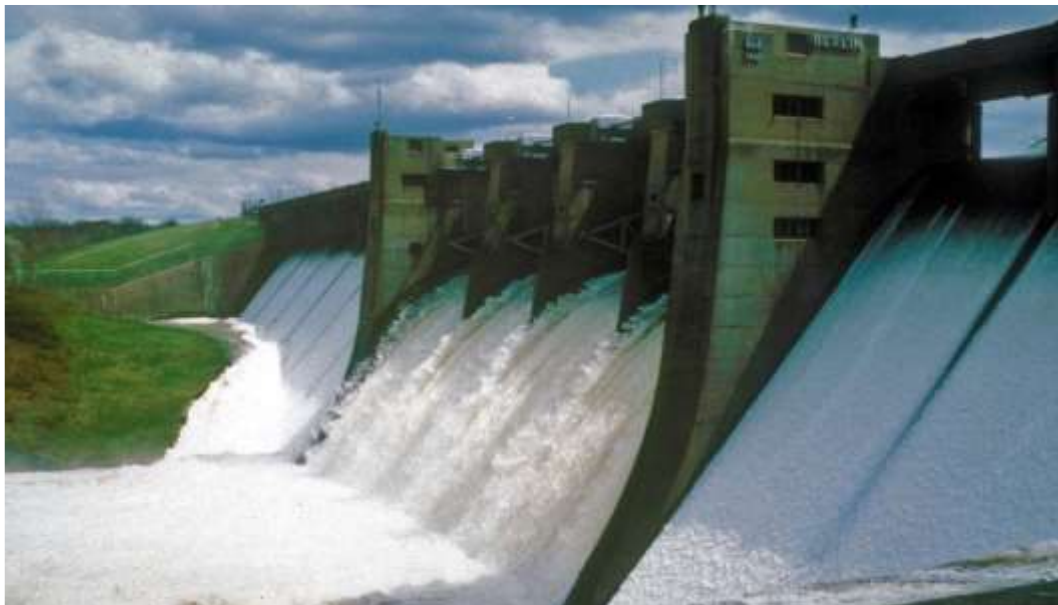
Figure IV.1 : Ecoulement à grande vitesse dans un coursier à grande pente
