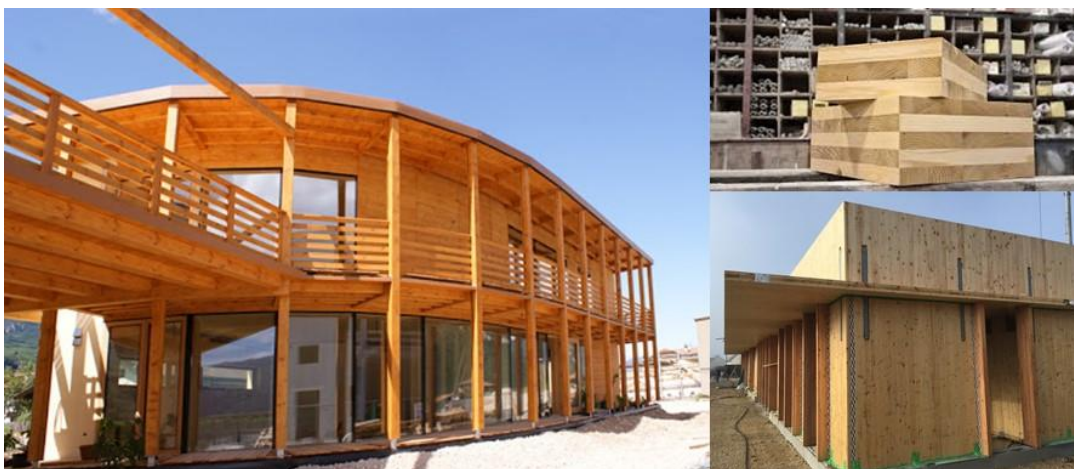
Figure 51: construction avec du bois lamellé croisé.
