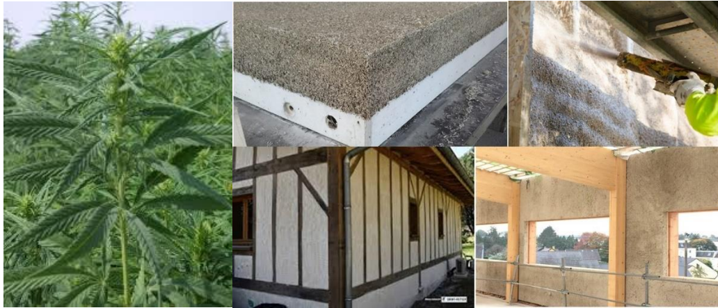
Figure 44:Le béton de Chanvre et système de construction en bois (© Tradical).
