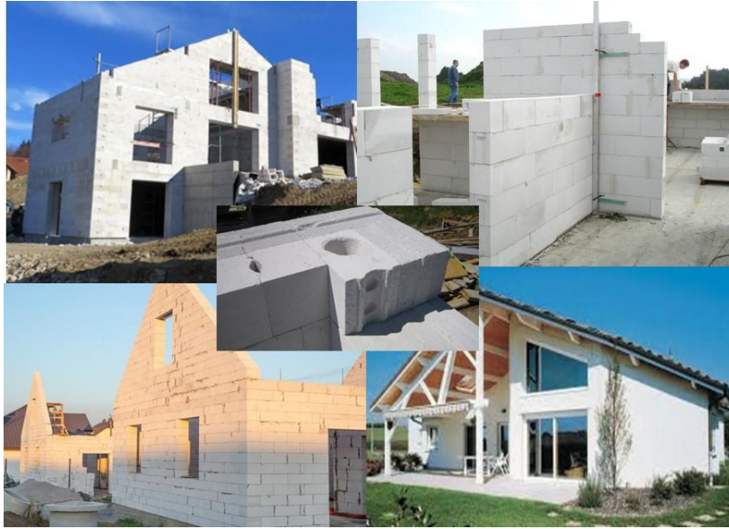
Figure 50: Construction avec des prique de béton cellulaire.
