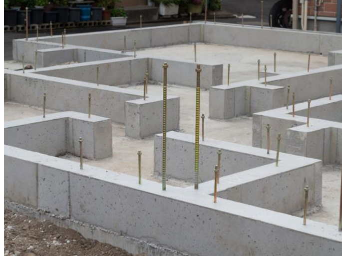
Figure 54: Construction avec le ciment zéro Carbon
